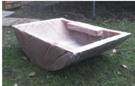
Betonbecken vor dem Einbau.
