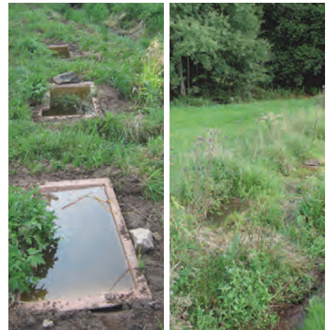
Kurz nach dem Einbau (li.) und nach einigen Wochen (re.).
