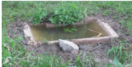
Becken vor (oben) und kurz nach dem Einbau (unten).
