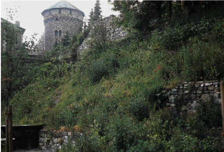
Diese Hangstützmauern der Stadt Stolberg, die früher auch zur Wäschebleiche genutzt wurden, sind durch schonende Restaurationsmaßnahmen freigestellt worden und fungieren nun wieder als Lebensraum für die Mauereidechse.
